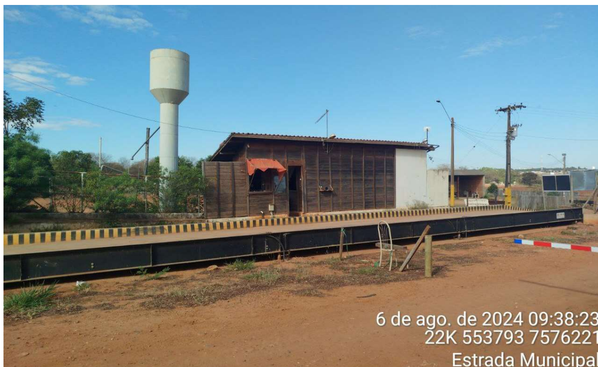
Foto 13: Balança para pesagem de caminhões – Entrada da Área de Transbordo/Usina de RCC.
