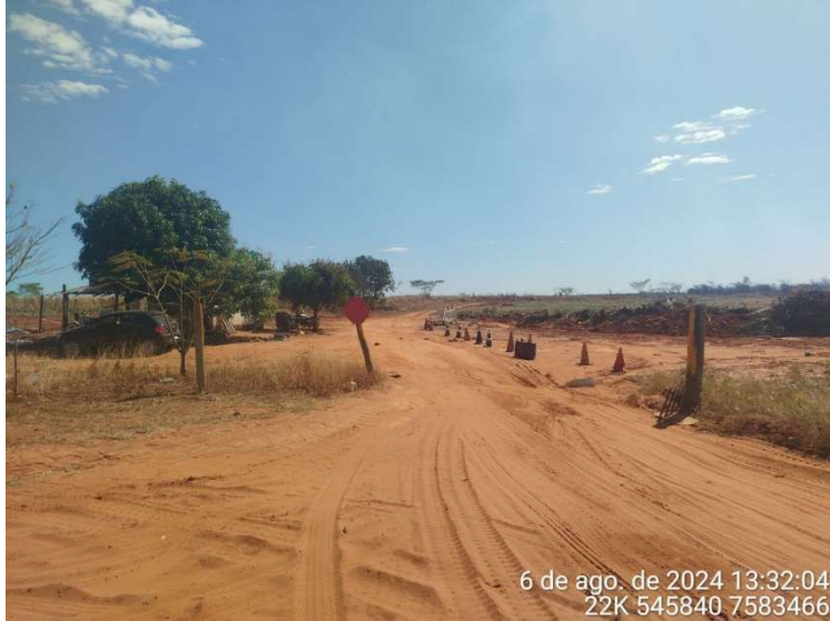
Foto 19: Acúmulo de Resíduos Verdes – ATT Municipal
