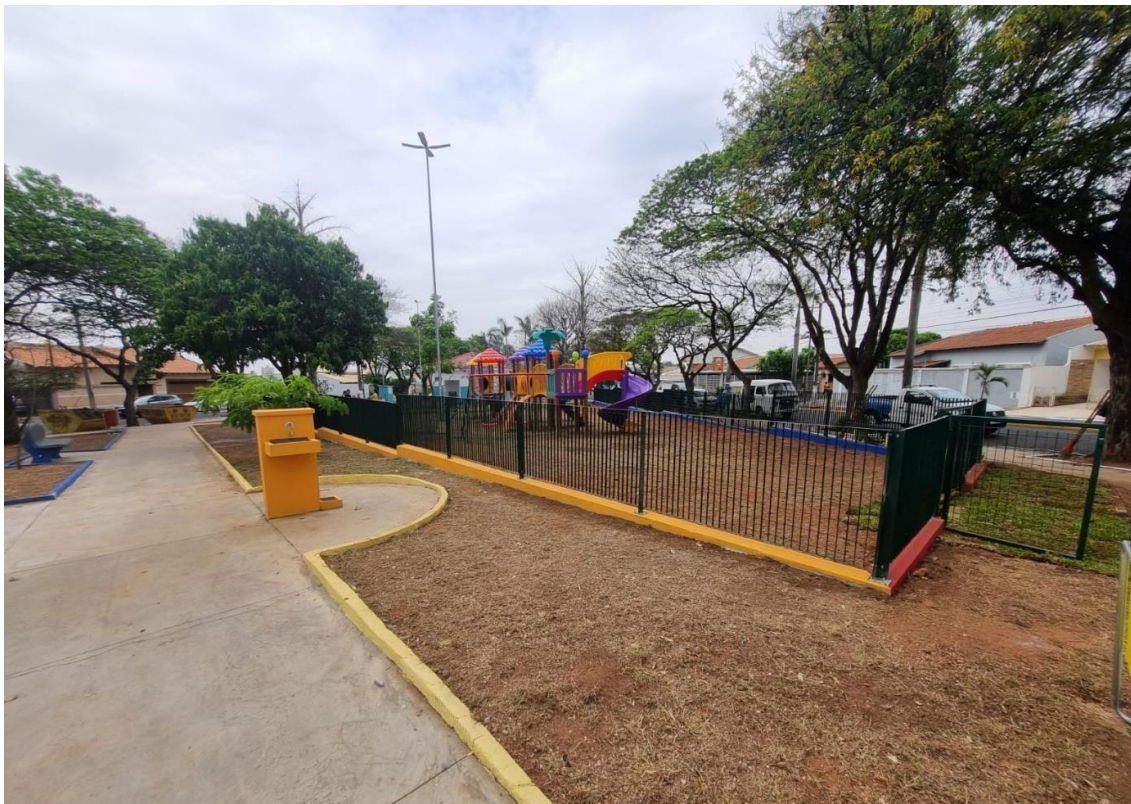
Imagem: Instalação de playground na praça Anísio Carneiro.
